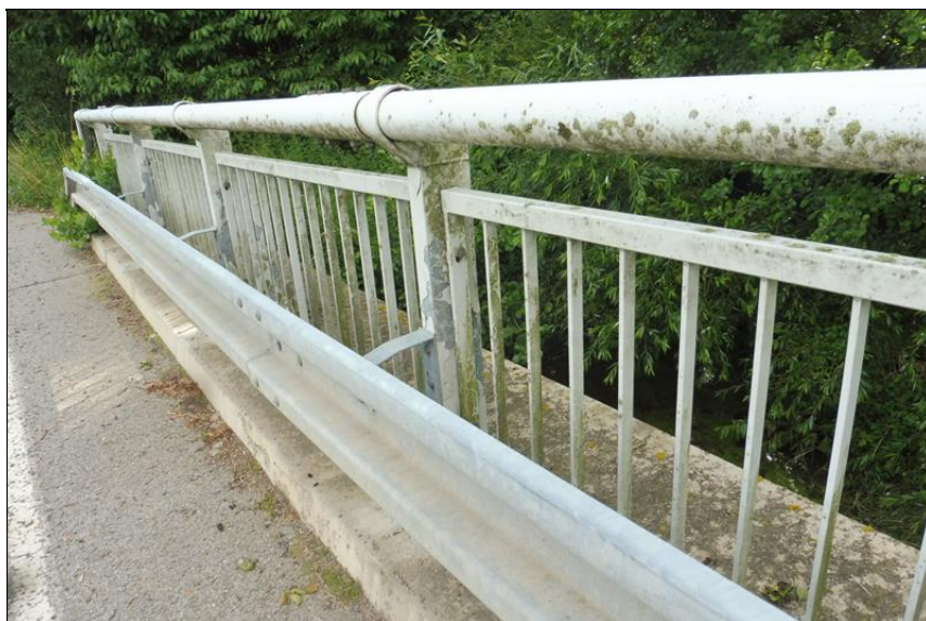
Zábradelní svodidlo vpravo.
