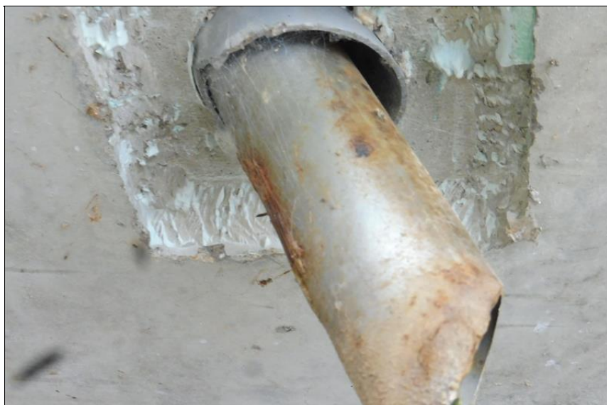
Vyústění trubičky odvodnění izolace.
