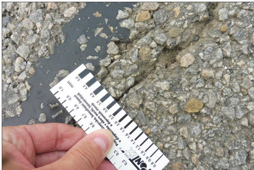
Trhliny ve vozovce.
